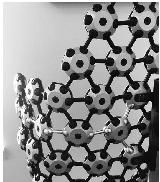
Particolare dei connettori di rinforzo in alluminio
